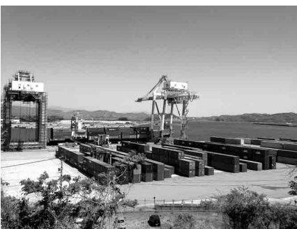
細島港 ガントリークレーン
